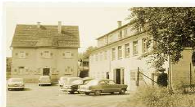
Budynki fabryczne w latach 50-tych.
